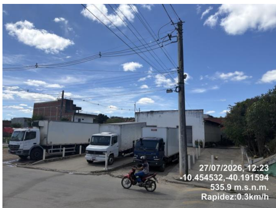
37 - Edificações construídas sobre o Riacho do Alambique (Canal da Malária) na Rua Carrapichel ao lado do pontilhão da ferrovia. Nesse local foi construído e funcionava um DAFA da Embasa para tratamento de esgoto das residências populares Pró-Morar, conhecida como Mutirão.
