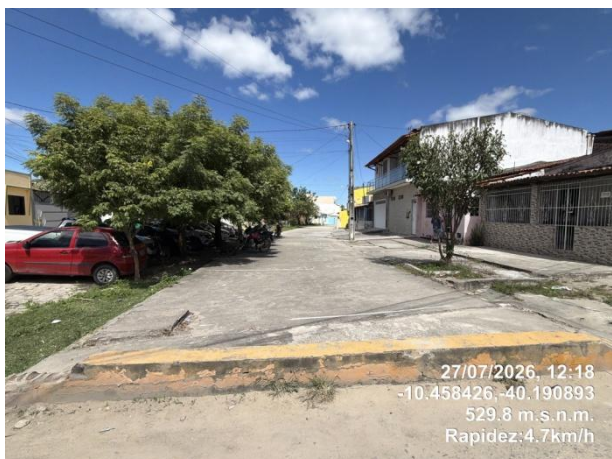
33 - Laje de cobertura do canal
