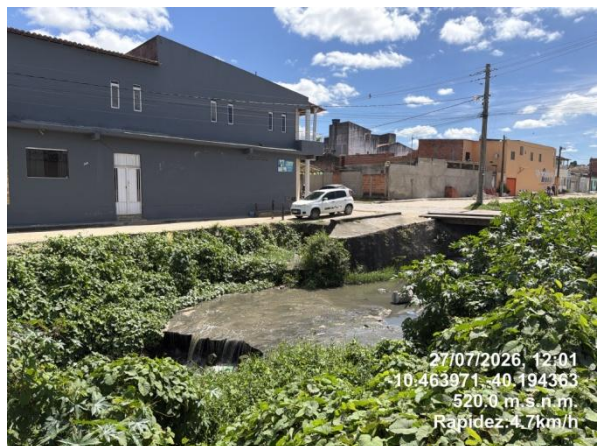
13- Edificação na APP do riacho do Alambique. Água com turbidez elevada, coloração escura e forte odor característico de aporte de esgoto sanitário.
