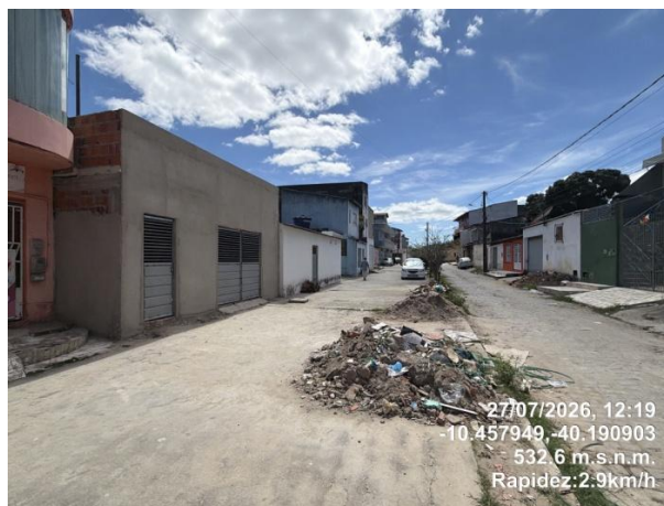
34 - RSCC depositado sobre a cobertura do riacho Alambique (Canal da Malária)
