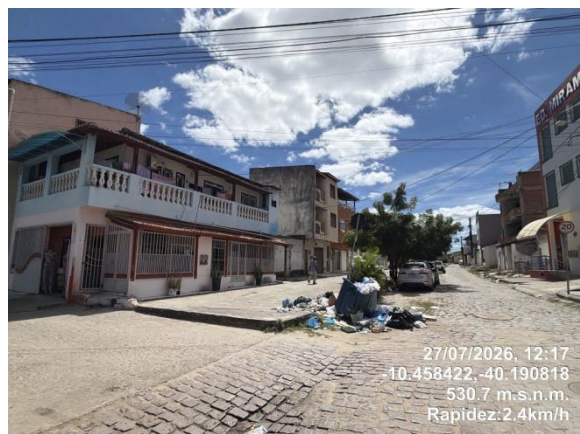
32 - Resíduos sólidos domiciliares dispostos na entrada das galerias de drenagem de águas pluviais do canal do rio Alambique. Pedestre trafegando sobre a laje do Canal.
