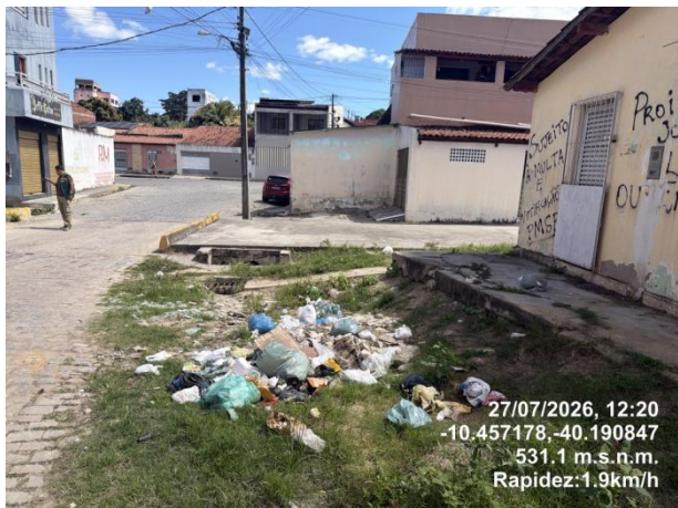
35 - Resíduos sólidos domiciliares dispostos nas entradas das galerias de escoamento de águas pluviais do Canal. Residências construídas às margens do canal. Ponte sobre o canal de Riacho do Alambique.
