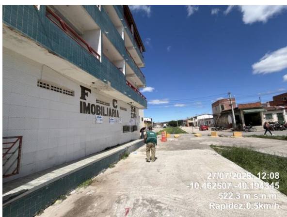
25 – Laje de cobertura do canal por onde escoo o riacho Alambique. Edificação construída à margem esquerda do Riacho Alambique. Local de Confluência dos Riachos.
