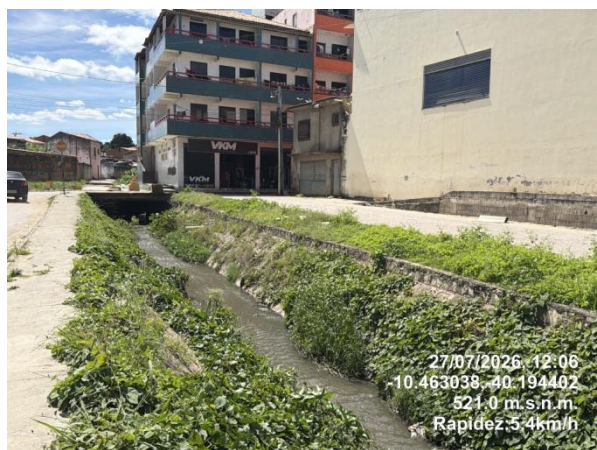
21 - Curso d'água com aporte de esgoto sanitário in natura com odor muito ativo e característico. Água com coloração escura. Observa-se falta de manutenção do revestimento do canal pela presença de vegetação nas vertentes ao longo do canal revestido com pedra argamassada. Observa-se edificação de múltiplos pavimentos construída na APP do Rio Alambique.
